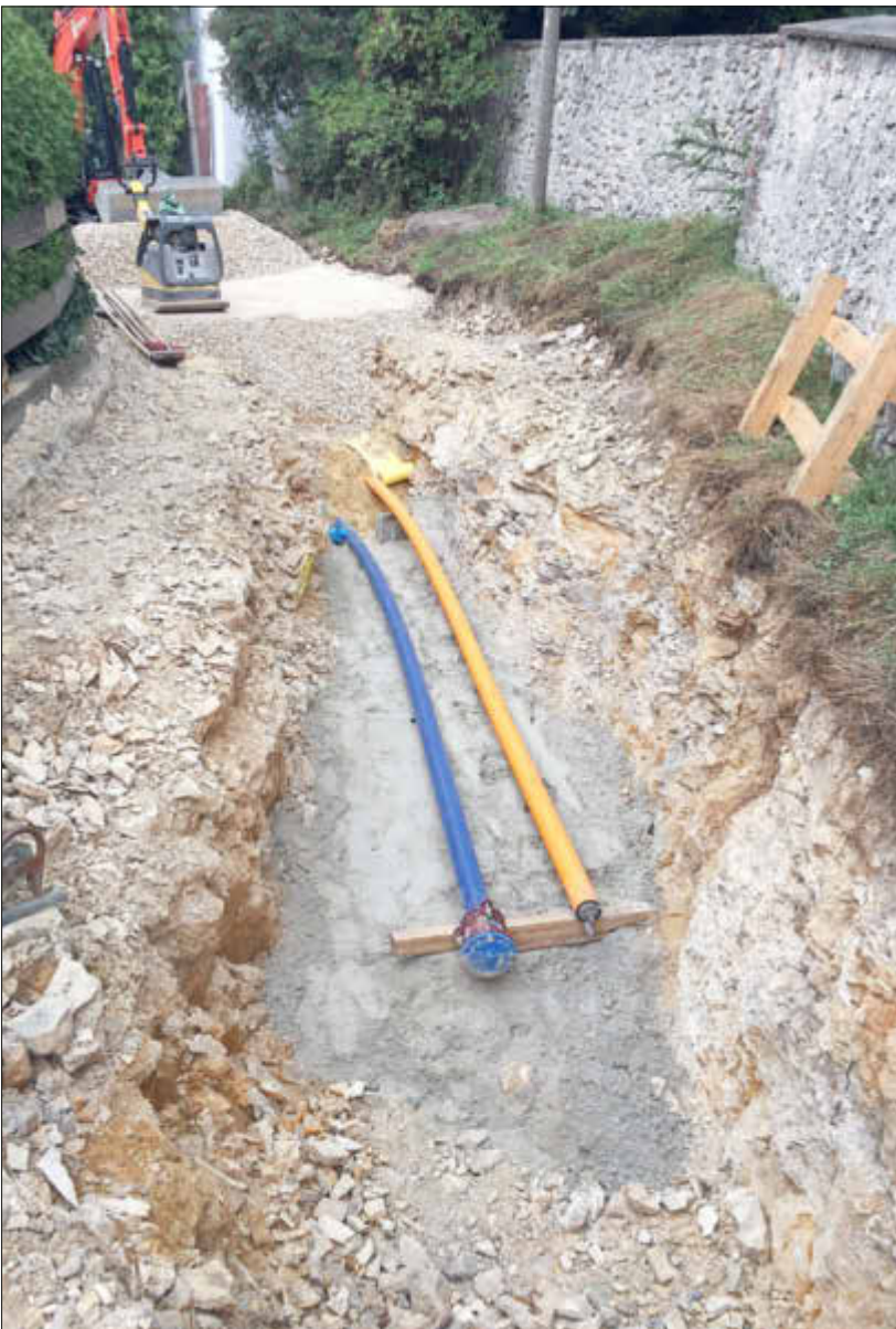
Verlegung v. Wasser, Gas und Glasfaser in der Bergstraße im August 2019 Foto: 1. BGM. Gensberger
