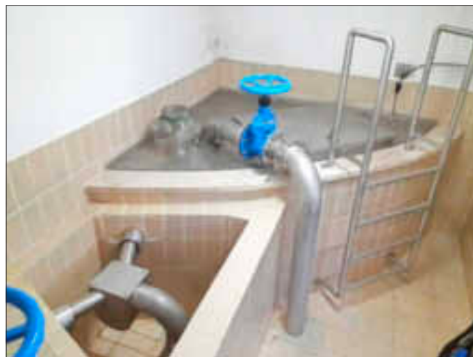
Hochbehälter Bergen fertig saniert zum Jahreswechsel 2020/2021 Foto: 1. BGM. Gensberger
